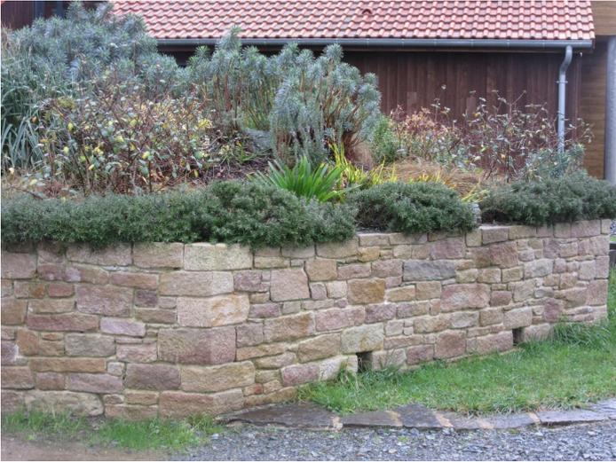
*Maçonnerie de pierres à la chaux.
